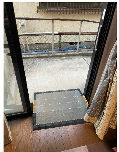
居間とスロープの間の段差改修
